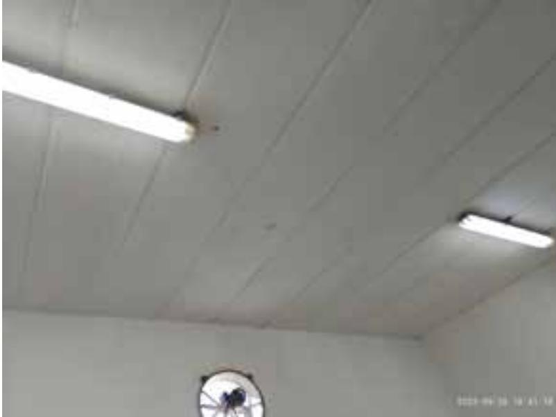
La ventilación del local de cocina es suficiente a pesar de la falta de extracción forzada en el interior de la campana sobre las hornallas de la cocina.
