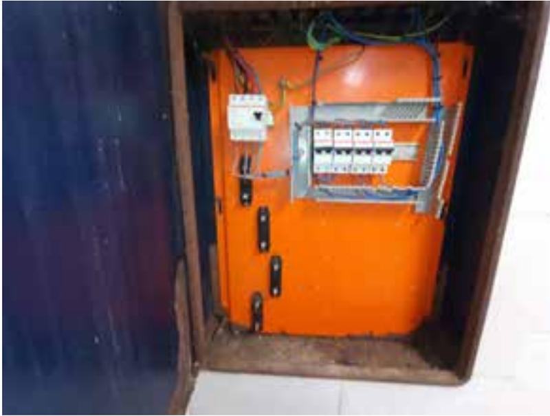
Los conductores eléctricos se observan expuestos sin tapa de seguridad para evitar contacto directo. No se observa protección a tierra en continuidad con la tapa de tablero.
