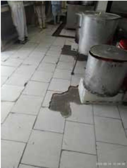
Las condiciones de los revestimientos en paredes y pisos no cumplen la condición de impermeabilidad, resultando además un riesgo de caídas y cortes para las personas que transitan el área.
