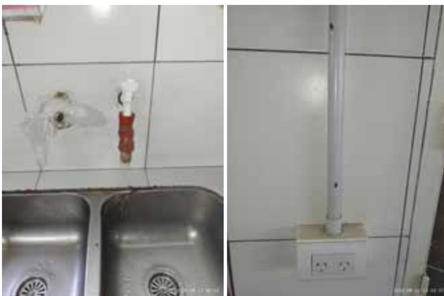
**Faltante de canilla en la pileta de la mesada. Presencia de insectos en el local de cocción de alimentos.**
