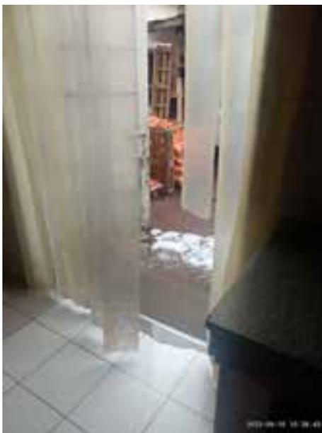
Las mesadas rotas no ofrecen una superficie completamente lisa. Las cortinas rotas permiten el ingreso de moscas; se observaron en todos los sectores durante la inspección.
